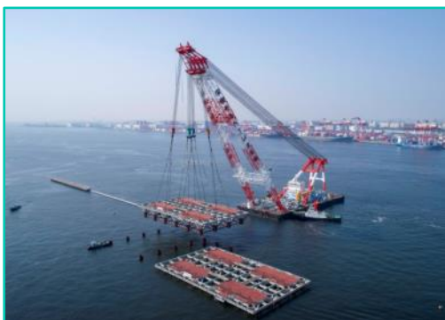
13号地新客船ふ頭岸壁駐車場等用地建設工事
