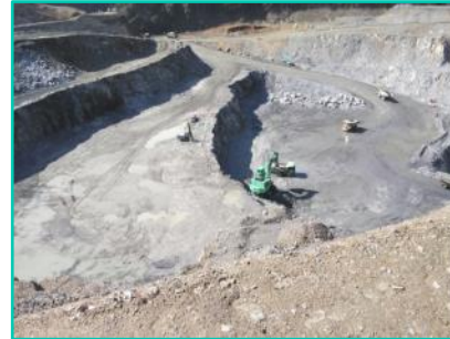
小石原川ダム工事 （爆砕工事）
