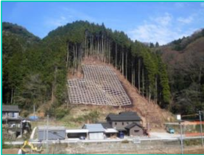
鶴地区治山工事 （法面保護工事）
