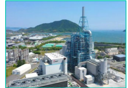
防府バイオマス発電所工事 （保温・耐火工事）
