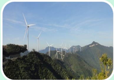
再生可能エネルギー関連工事
