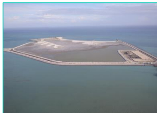
中城湾港土砂処分場護岸築造工事
