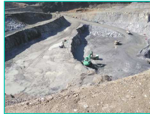
小石原川ダム工事 (爆砕工事)
