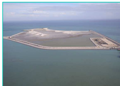
中城湾港土砂処分場護岸築造工事
