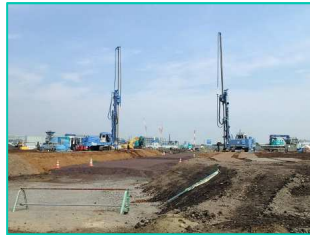
羽田空港跡地基礎盤整備工事 (地盤改良工事)
