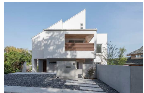
タツミプランニング 施工物件
