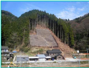
鶴地区治山工事 (法面保護工事)
