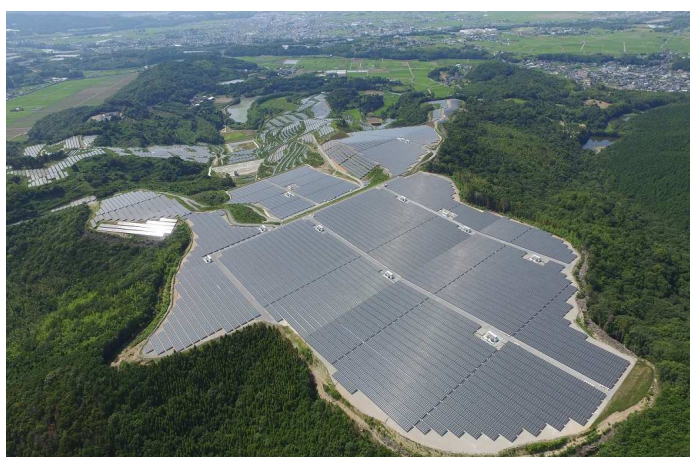
SGET宇佐メガソーラー発電所 土木造成工事 (株式会社日立製作所)
