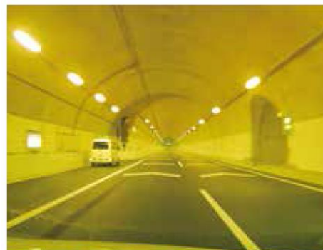
事故・落下物・故障車などの異常発生時に黄色点滅 サイン照明
