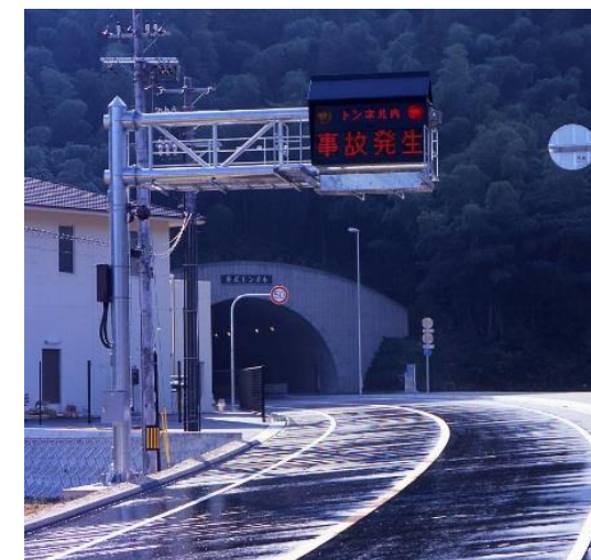
トンネル警報表示板
