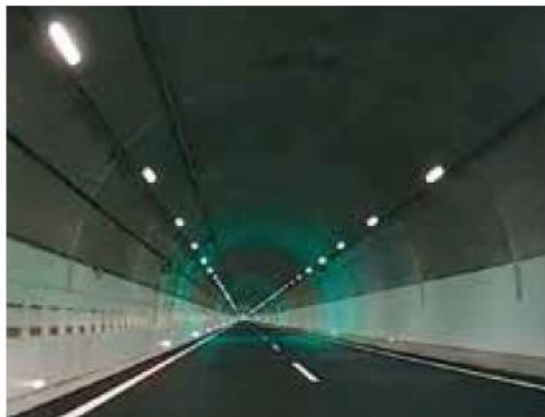
トンネル照明が緑色点灯して進行方向に向かって光が移動
