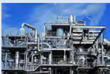
プラント監視制御システム
