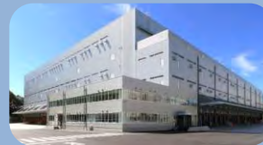
八王子配送センター
