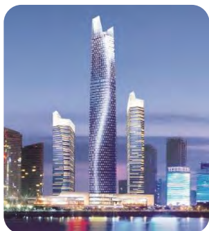
中国 青島国信海天中心 〈青島国信海天中心建設〉
