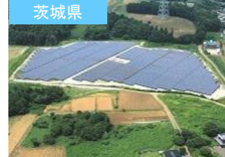
S-12 LSつくば房内発電所
