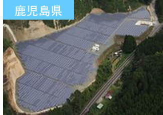
S-05 LS霧島国分発電所
