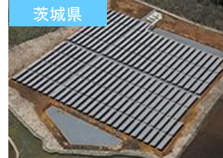
S-08 LS水戸高田発電所
