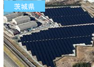
S-10 LS利根布川発電所
