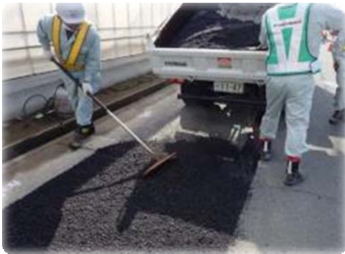
従来の処理工法 (補修材料：加熱アスファルト混合物)
