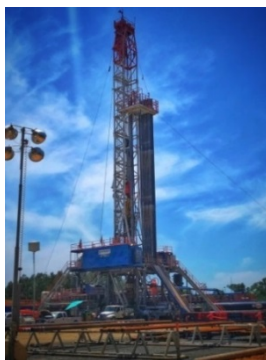
井戸掘削現場
