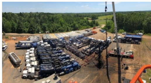
水圧破碎現場
