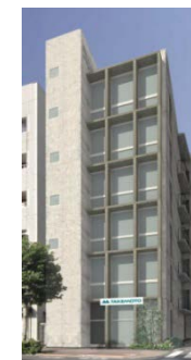
TOGETHER LAB(建設中)
