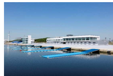
平成27年度海の森水上競技場整備工事(東京都)
