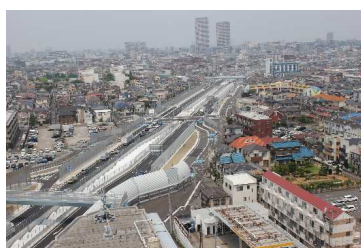
東京外環自動車道 大和田工事(千葉県)
