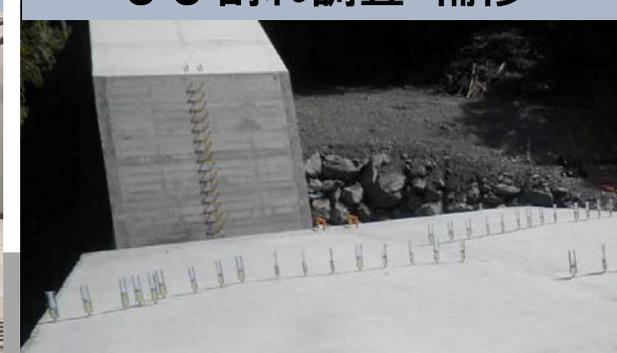
震災でも橋梁が倒壊しないように補強工事が進んでいます。
