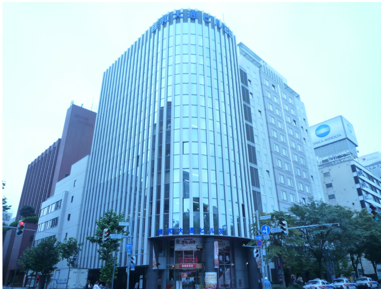
<Sapporo Sales Branch（札幌営業所 [サッポロ セールス ブランチ]）入居予定の桂和大通ビル外観>
