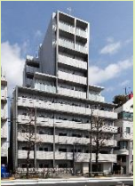
GENOVIA武蔵関公園 skygarden
