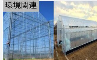
農業用のパイプハウス、鉄骨製ハウス (グリーンハウス)
