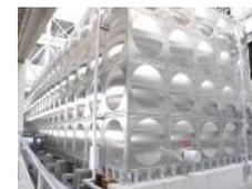
非常用の水栓を取り付けることで受水槽内に貯水されている水を供給することが可能
