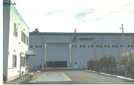
燃料棟(左は事務所棟)
