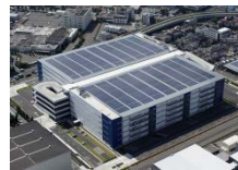
評価Sランク ★★★★★ ロジポート橋本
