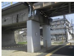
落橋防止対策
