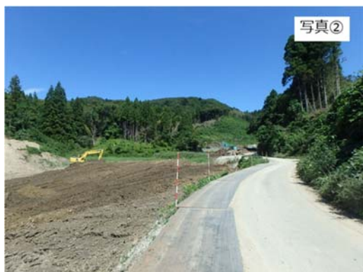
伐採工事により発生した抜根の処理及び家屋の解体工事中です
