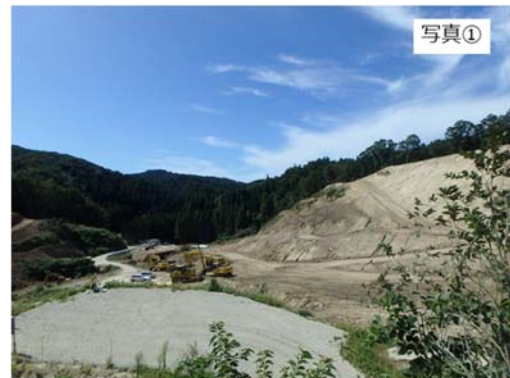
防災調整池付近の造成工事を進めています
