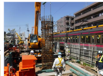
基礎杭の構築
