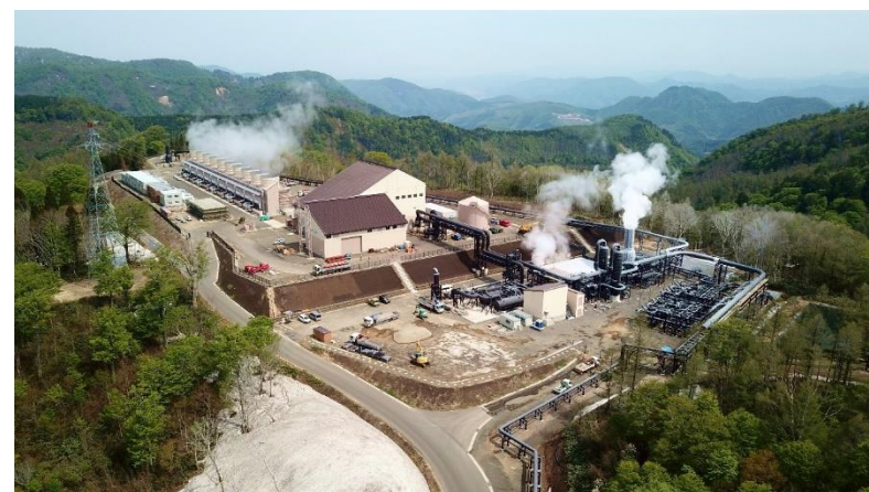
山葵沢地熱発電所
