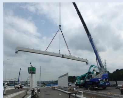
首都高横浜環状北西線標識新設 (神奈川県)
