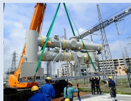
交流変電所電気設備新設 (神奈川県)
