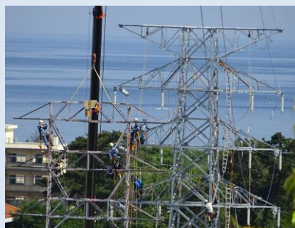
日本製紙江津線鉄塔建替 (島根県)
