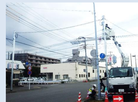
交通信号機新設 (静岡県)
