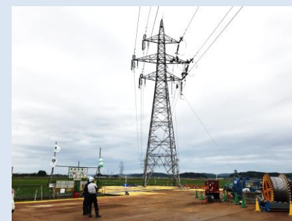
南新潟線電線張替 (新潟県)
