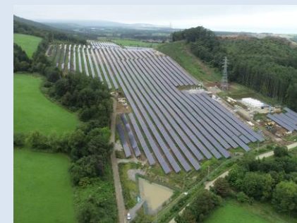
紋別市弘道太陽光発電所建設 (北海道)
