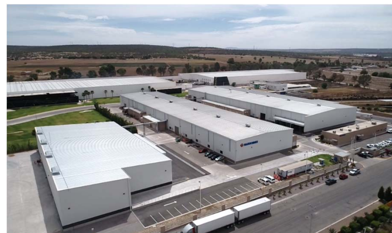
切断工場 (2019年4月完成)
