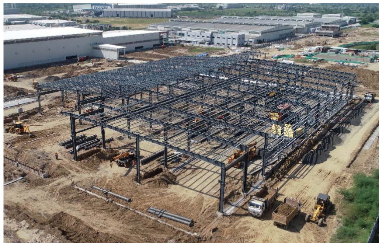
グジャラート工場(建設中)
