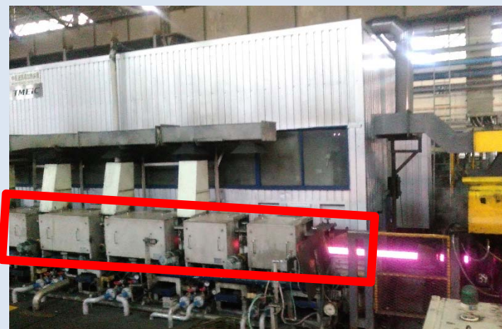
堺工場 SR加熱機更新 2019年5月 更新工事完了
