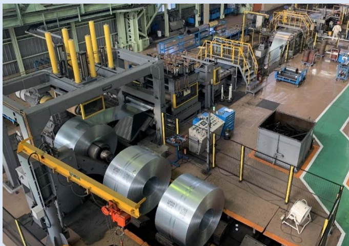
東京工場 No.1スリッター更新 2019年5月 更新工事完了
