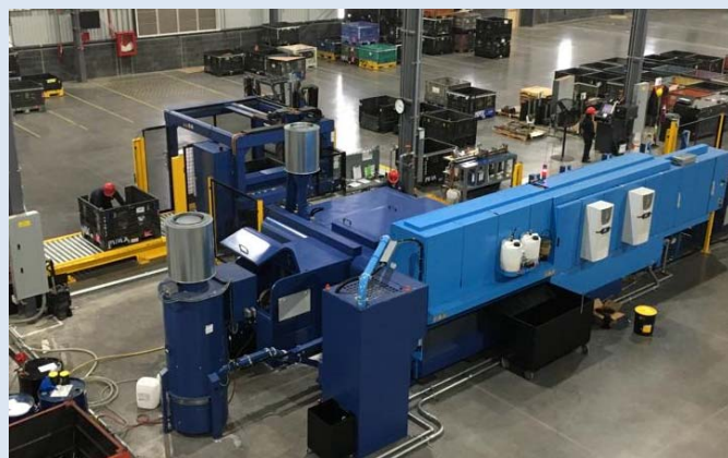
メキシコMMX社 切断機増設 2019年9月 設置完了
