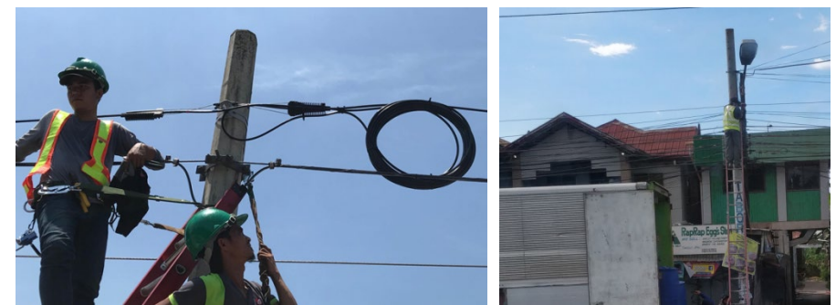
ミンダナオ島各地で工事を進めております。(CDO 2019年11月)
