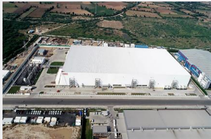
インド・グジャラート州 19年10月建屋完成
