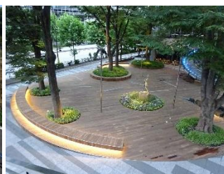
エムズ 霞が関ビルディング けやき広場ウッドデッキ更新工事(主)十日町中間塩沢線県単舗装道補修工事
