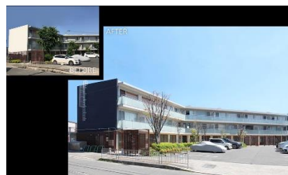
高松テクノサービス(大阪) RC造3階建て 賃貸マンション外壁リフレッシュ工事
