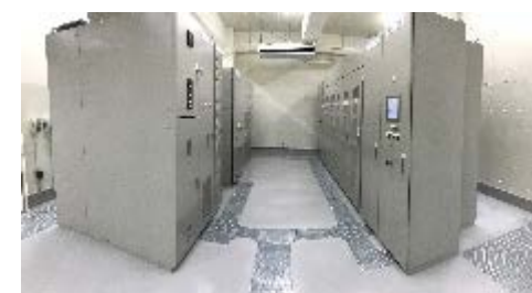
沖縄モルレル向け回生電力貯蔵装置 余剰回生電力を地上蓄電設備に充電し、省エネ、電圧降下補償、非常走行電源供給を実現
