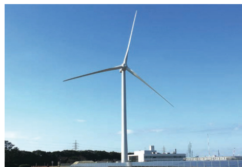
エネ・シード北九州風力発電所
