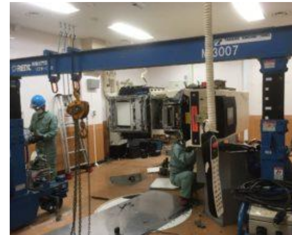
【屋内での解体作業状況】
