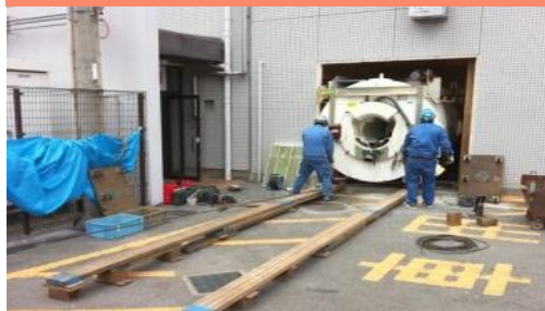
壁面切断・MRI撤去
