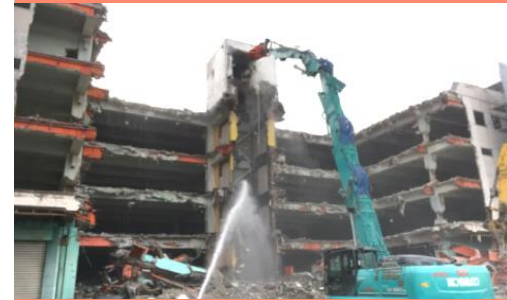
鉄筋コンクリート造解体
