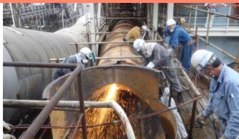
プラント ガス解体
