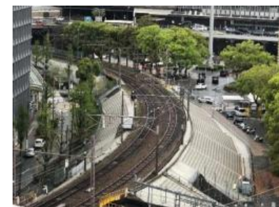
斜面防災対策 (新大阪駅付近)
