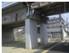
落橋防止対策
