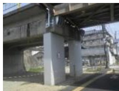
落橋防止対策
