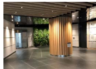
エントランスリニューアル工事(新横浜TECHビル)
