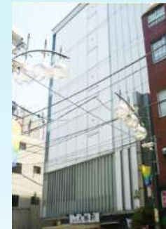
Box'R新橋ビル
