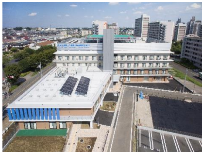
青木あすなろ建設 (仮称)介護老人保健施設久米川 新築工事
