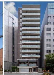
高松建設 大阪 豊崎・Hマンション
