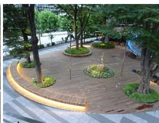
エムズ 霞が関ビルディング けやき広場ウッドデッキ更新工事(主)十日町日間塩沢線県単舗装道補修工事
