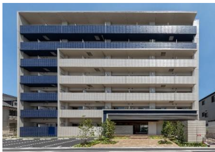
高松建設 大阪 放出・O社寮
