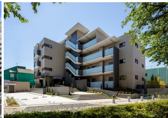
高松建設 東京 浦安・Wマンション
