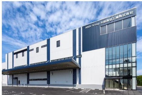
青木あすなろ建設 (仮称)大阪真空工業(株)星田工場新築工事
