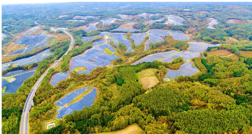
「軽米東ソーラー発電所」全景
