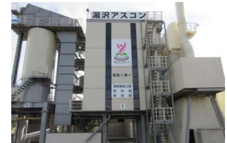
湯沢合材工場
