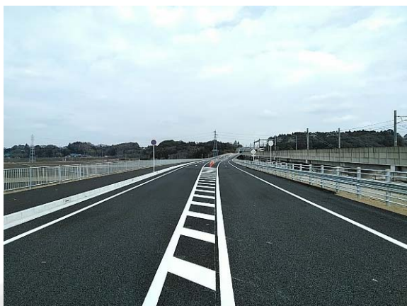
北千葉道路舗装工事
