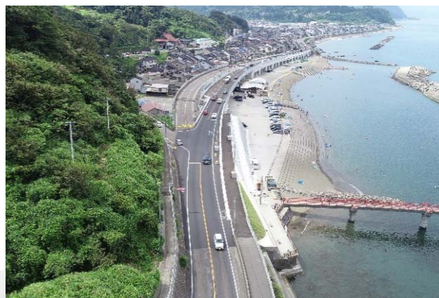
弁天大橋架替舗装工事
