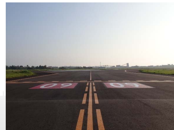
宮崎空港誘導路改良工事
