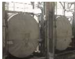
オートクレーブ養生
