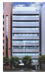
KDX新日本橋駅前ビル
