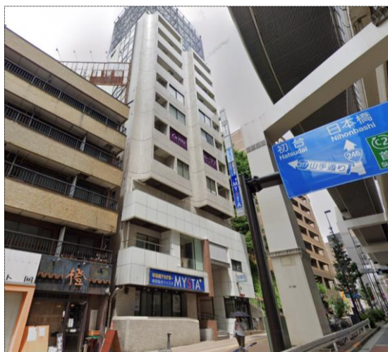
▲池尻大橋駅前店舗ビル
