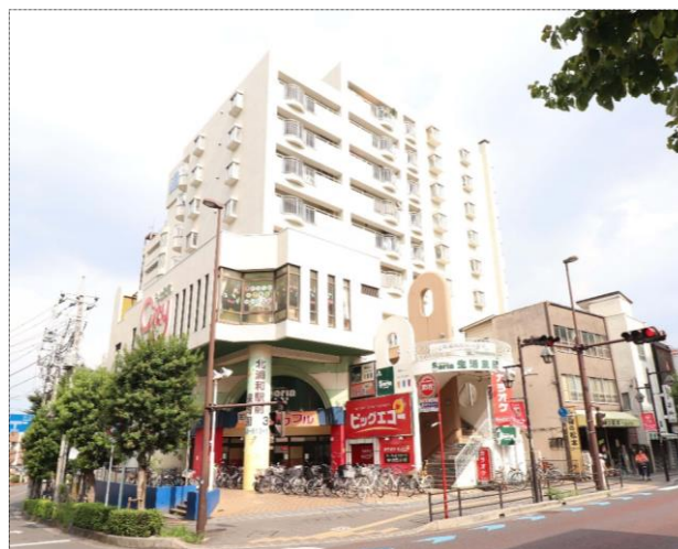
▲北浦和駅前店舗ビル
