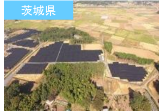
S-23 LS桜川中泉発電所
