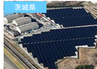
S-10 LS利根布川発電所
