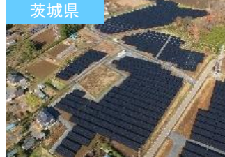
S-19 LS桜川下泉発電所
