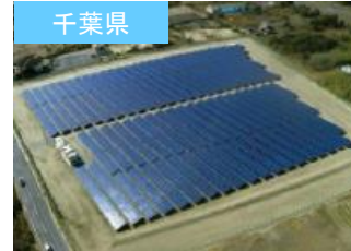
S-06 LS匝瑳発電所
