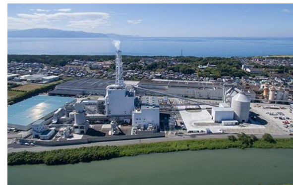
<鈴川エネルギーセンター株式会社殿 火力発電所 外観>
