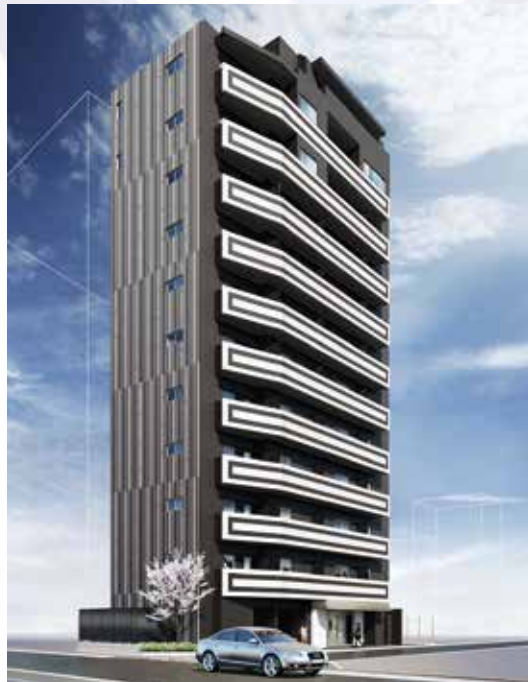
AXAS 駒込アジールコート
