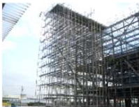
大規模倉庫 屋根成形工事
