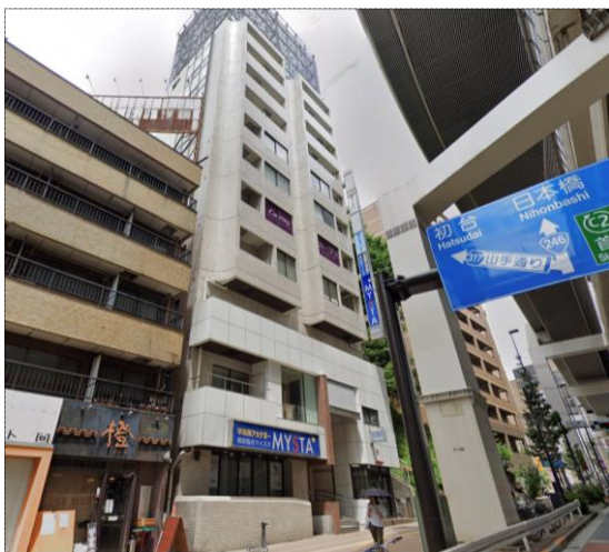
▲池尻大橋駅前店舗ビル
