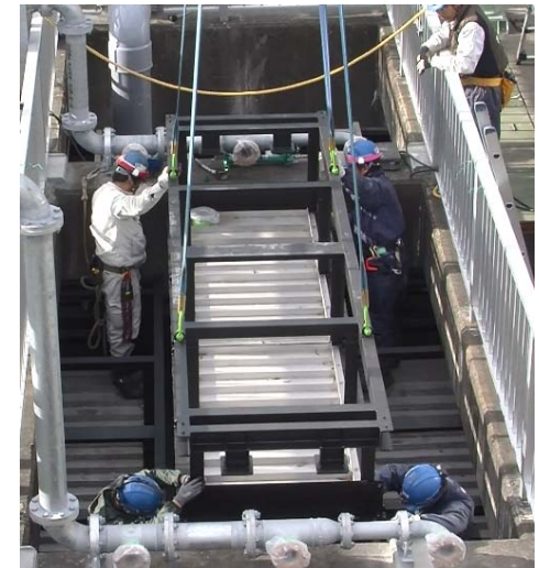
既存終沈にカセット型ろ過槽を導入することで終沈の水量を増強
