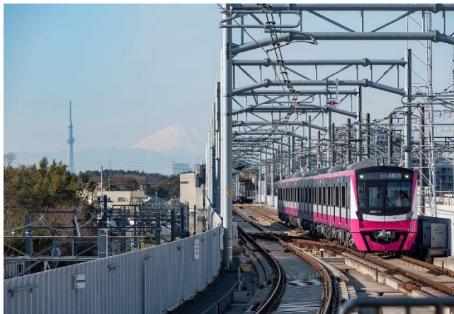
北初富駅～新鎌ヶ谷駅間
