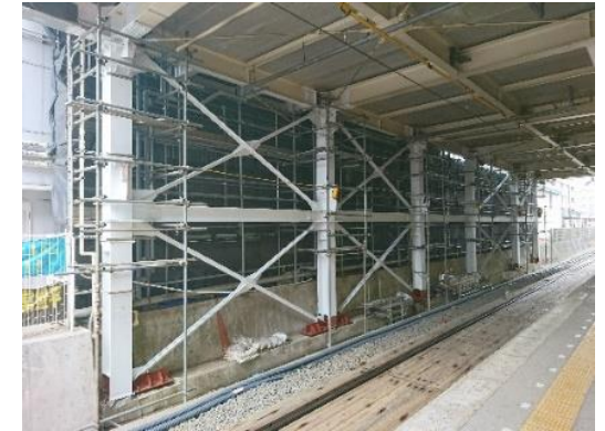
常盤平駅耐震補強
