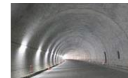
石炭灰を再利用したコンクリートによるトンネル覆工
