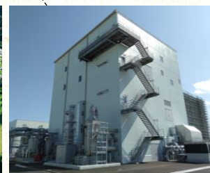
鹿島(日本) 写真は建設中のF-5棟
