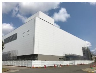
川島(日本) 写真は建設中の第5製剤棟
