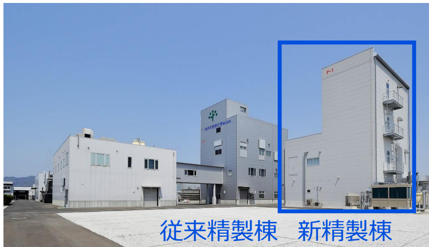
出雲工場 医薬原薬精製棟
