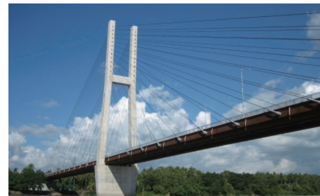
フィリピン 第二マグサイサイ橋・バイパス道路建設事業
