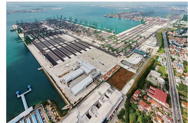
シンガポール バシルバンジャン・ターミナル建設工事(第3期/第4期)
