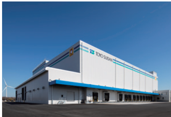
北海道小樽市 (仮称)東洋水産株式会社石狩物流センター新築工事
