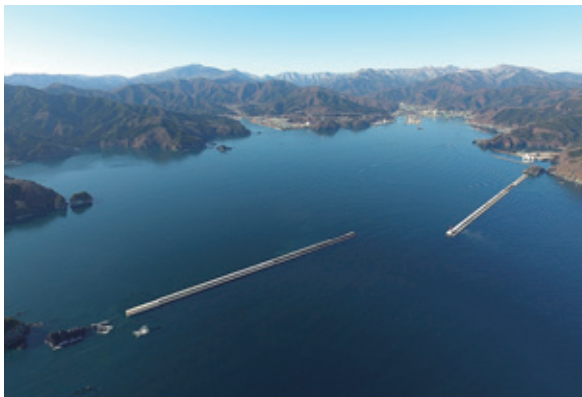
岩手県釜石市 釜石港湾口地区湾口防波堤(災害復旧)(北堤)築造工事
